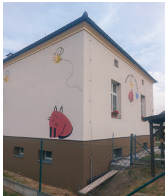
Revitalizace fasády budovy MŠ.
