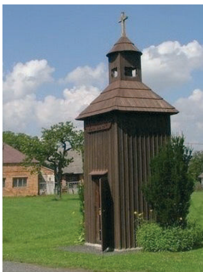
Planiny u Nových Mitrovic – bedněná zvonice/kaple.
