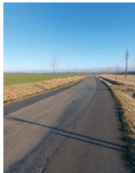
Oprava komunikace ve směru na Rpety.
