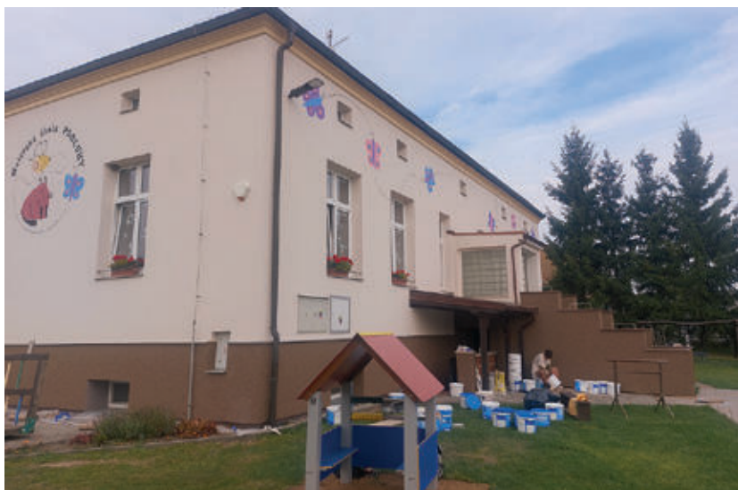
Budova MŠ po dokončení prací.
